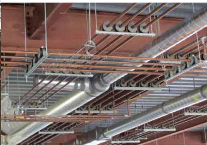
La préfabrication renferme une multitude d'avantages pour les installateurs et leurs clients. L'avantage numéro 1 est le gain de temps. En effet, la fabrication modulaire permet de compresser le calendrier du chantier jusqu'à 18%. Cela permet non seulement de finir le chantier plus rapidement et présente également bien d'autres intérêts.
